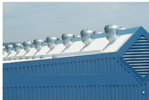
Tornades en combinaison avec des grilles de fumée.
