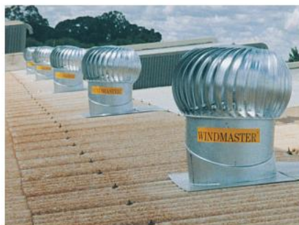
Pente de tornades montée sur un toit en amiante.
