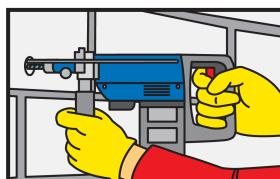
Forer le trou au diamètre et à la profondeur requis, en fonction de la dimension de l'ancrage.
