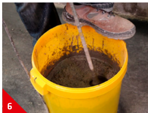
6 Mélanger 3 min à l'hélice 4 branches
