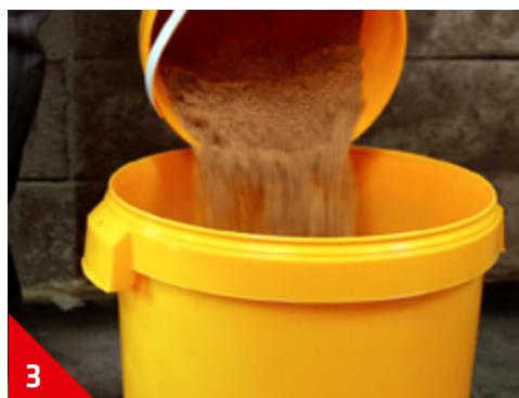
3 Verser 20 volumes de sable dans un seau vide (ex: 10 l)
