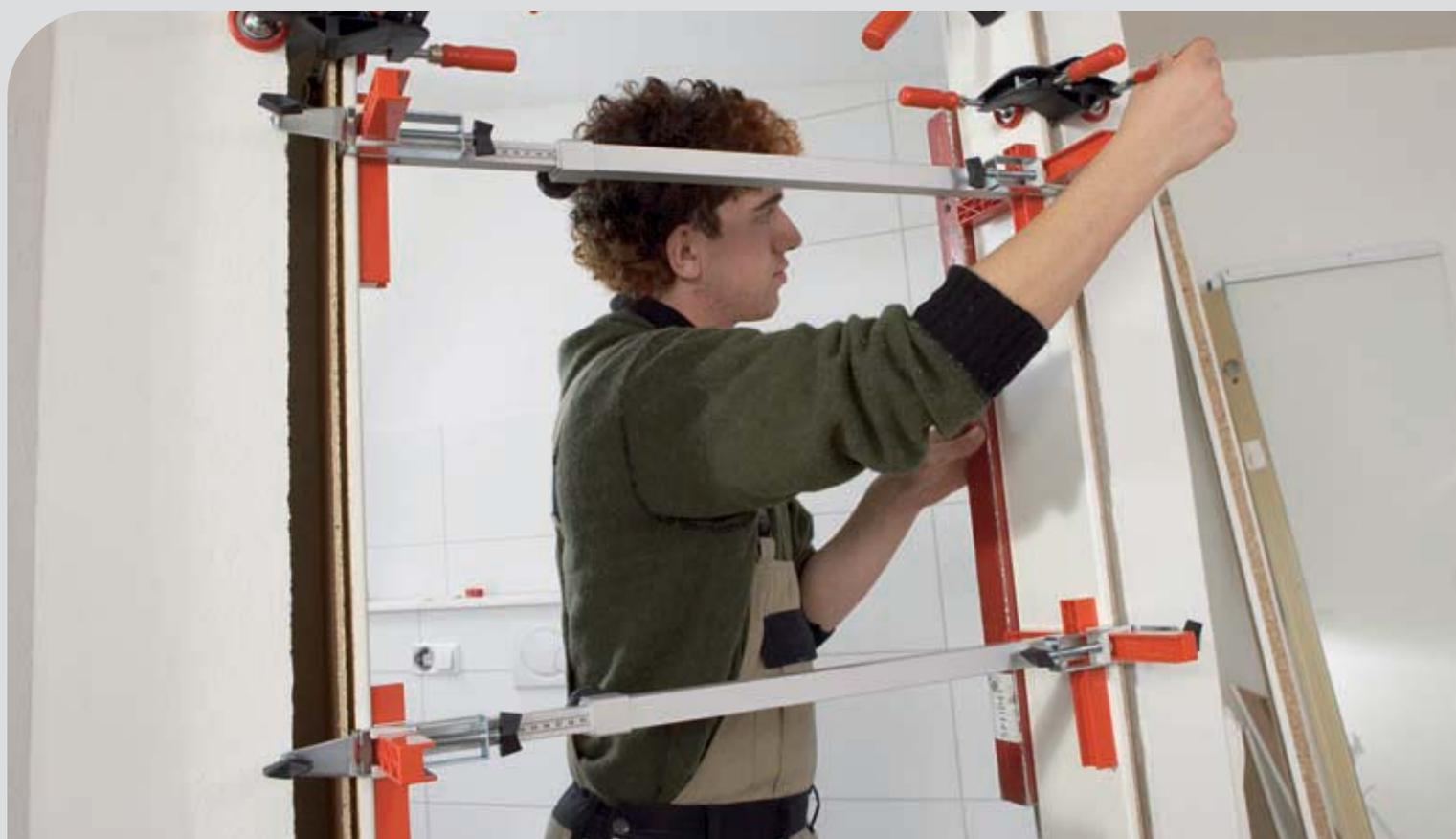
Des montages faciles avec des outils adaptés. Les montages de cadre de portes exige des outils adaptés pour un bon alignement et un bon maintien des pièces à ajuster.
