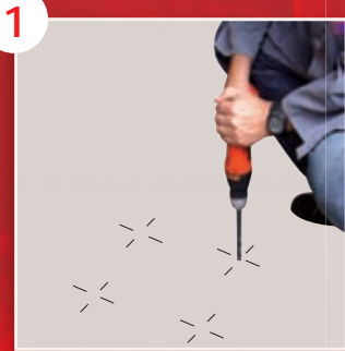
1 Perçage des trous de fixation
