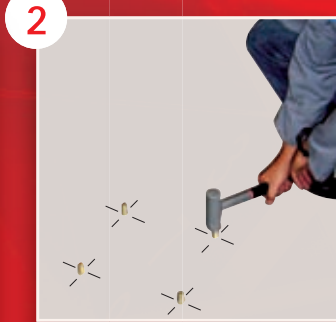
2 Mise en place des goujons
