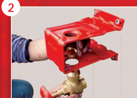
Positionnement du robinet d'arrêt
