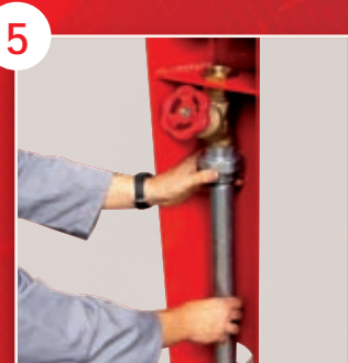
5 Raccordement de l'alimentation
