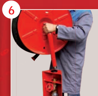
6 Mise en place de la bobine
