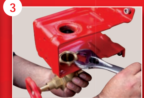
Fixation du robinet d'arrêt
