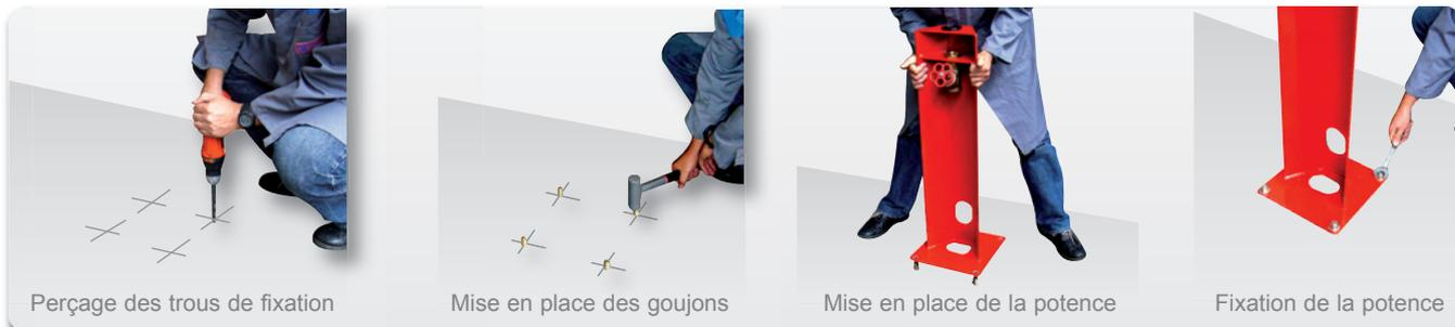
Perçage des trous de fixation
