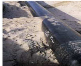
Joints de soudure
